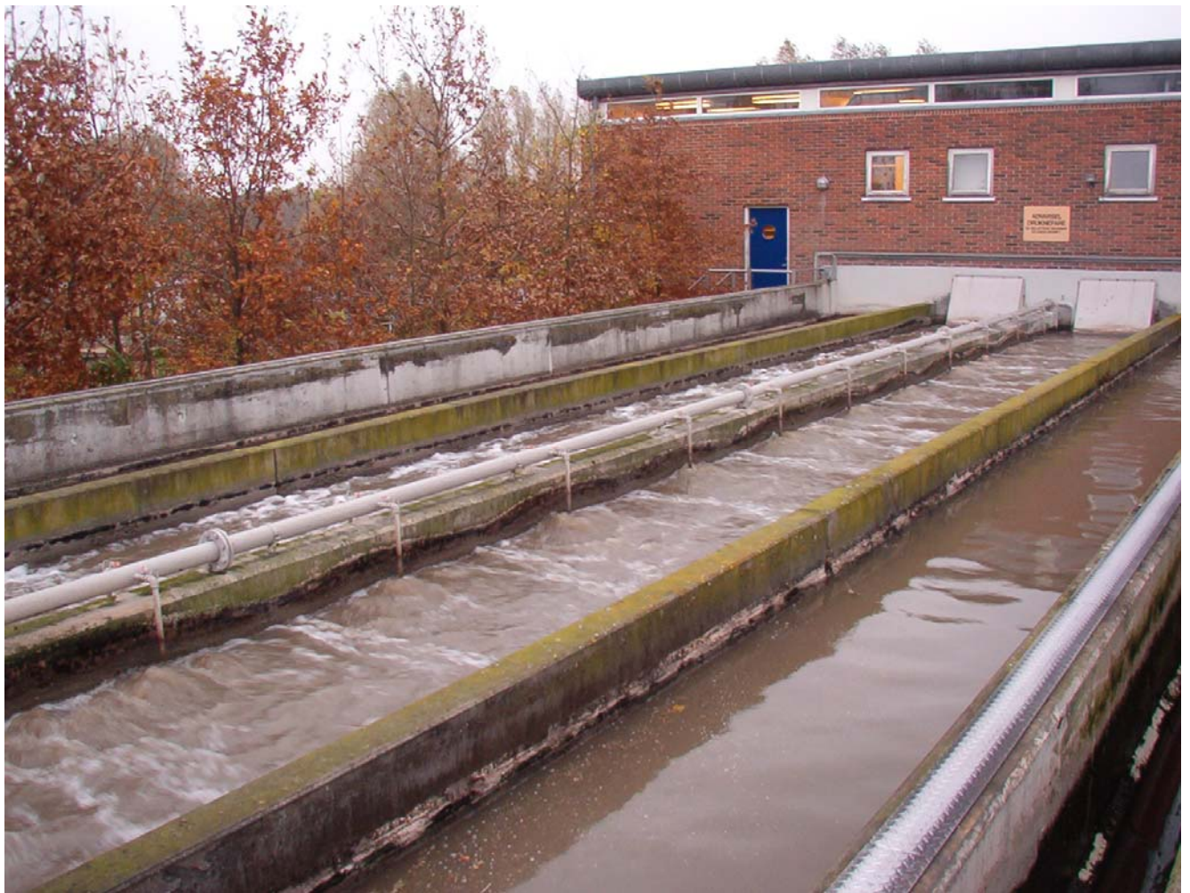
Om eftermiddagen var vi ude at se Ballerup's Rensningsanlæg
